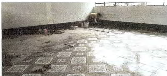
Foto 4: REPARACION O SUSTITUCION DE PISO
