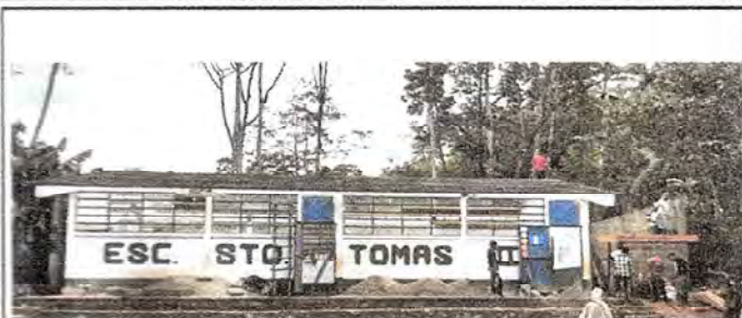
Foto 1: CUBIERTA DE LAMINA
