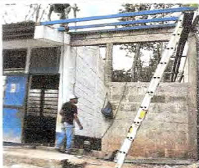
Foto 3: ESTRUCTURA METALICA, ENTECHADO, PISO, PUERTA Y VENTANA. DIRECCION SEGÚN CROQUIS
