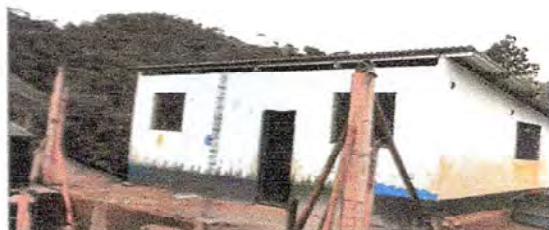
Foto 5: REPARACION DE CORREDOR
