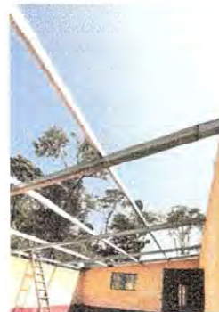
Foto 2: ESTRUCTURA DE TECHO
